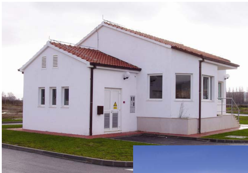
Uređaj za pročišćavanje otpadnih voda u Sinju
